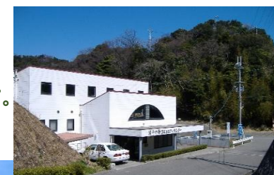
管理事務所 卓球場・シャワー室
